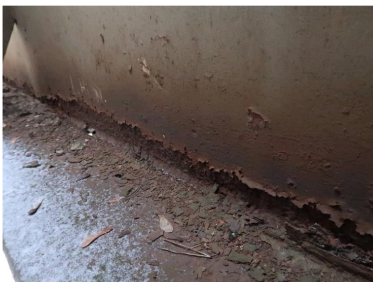
Foto č. 2 Konstrukce K 01 – levý hlavní nosník, konec, vni - oslabení stojny
