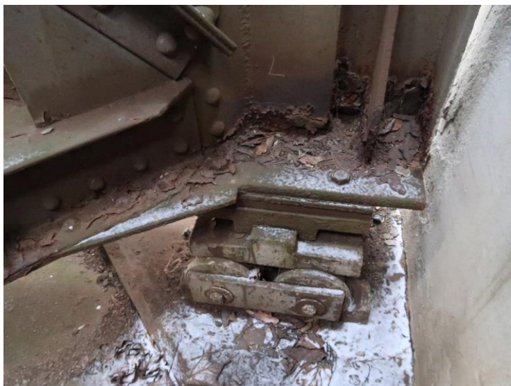
Foto č. 1 Konstrukce K 01 – levý hlavní nosník, konec, vni - oslabení
